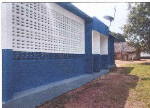
FOTO 53 PINTURA - APLICAÇÃO DE TINTA ACRÍLICA
