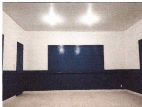
FOTO 44 INSTALAÇÕES ELÉTRICAS - LÂMPADAS
