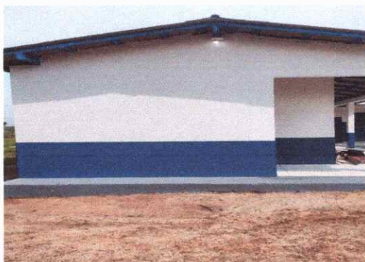
FOTO 51 PINTURA - APLICAÇÃO DE TINTA ACRÍLICA
