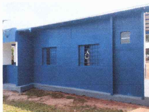
FOTO 52 PINTURA - APLICAÇÃO DE TINTA ACRÍLICA
