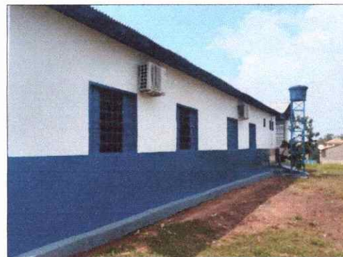
FOTO 54 PINTURA - APLICAÇÃO DE TINTA ACRÍLICA
