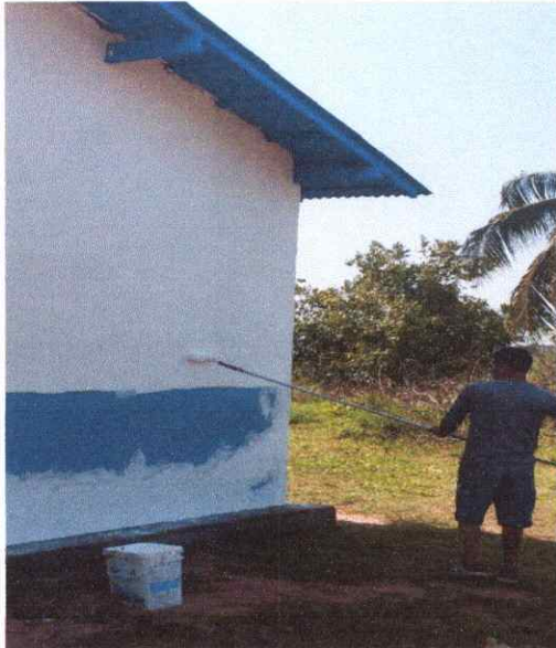
FOTO 135 APLICAÇÃO DE TINTA ACRILICA
