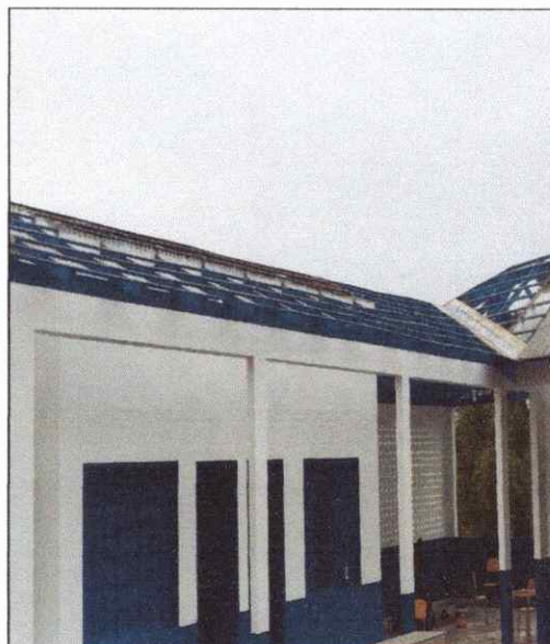
FOTO 156 EXECUÇÃO DE TRAMA E TELHAMENTO
