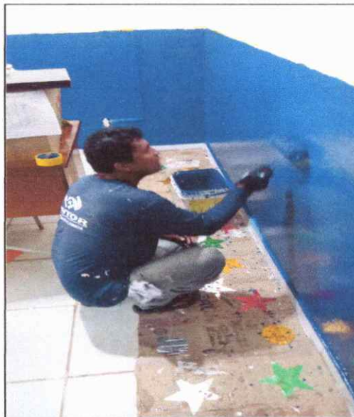
FOTO 54 APLICAÇÃO DE TINTA ACRILICA
