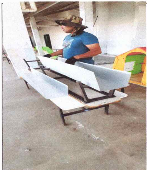
FOTO 31 INSTALAÇÃO DE CALHA EM CHAPA DE ZINCO
