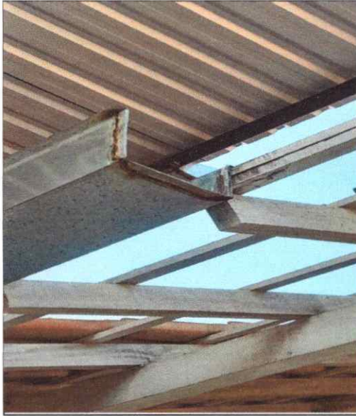
FOTO 33 INSTALAÇÃO DE CALHA EM CHAPA DE ZINCO
