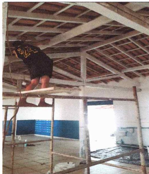
FOTO 50 APLICACAO DE TINTA ESMALTE EM MADEIRA
