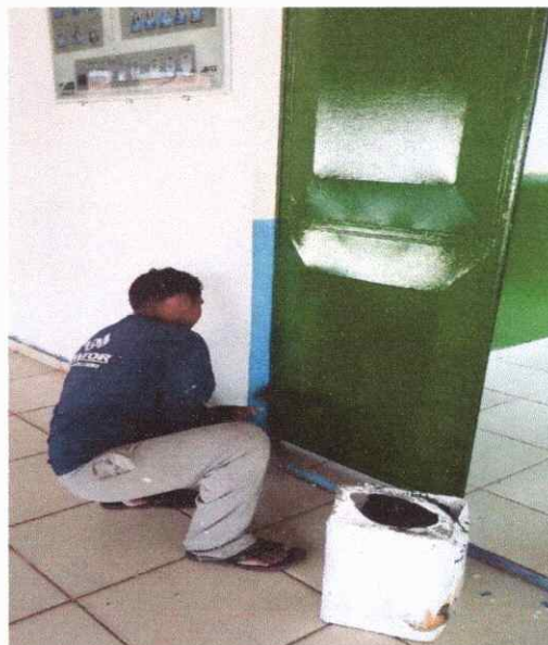
FOTO 74 APLICAÇÃO DE TINTA ACRILICA
