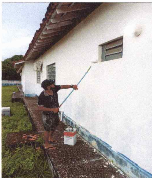
FOTO 41 APLICAÇÃO DE TINTA ACRILICA
