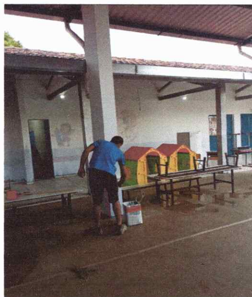
FOTO 42 APLICAÇÃO DE TINTA ACRILICA
