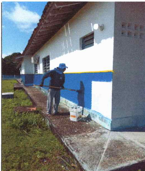
FOTO 47 APLICAÇÃO DE TINTA ACRILICA
