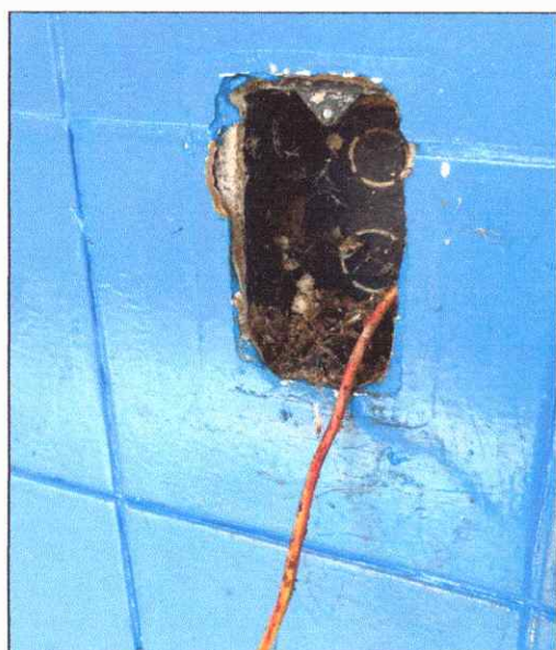
FOTO 97 ANTES DA MANUTENÇÃO
