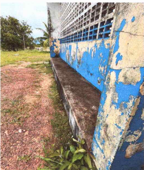
FOTO 117 ANTES DA MANUTENÇÃO
