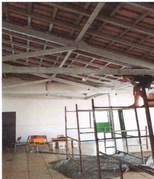
FOTO 49 APLICACAO DE TINTA ESMALTE EM MADEIRA
