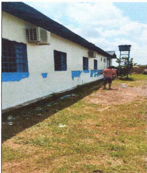
FOTO 131 APLICAÇÃO DE TINTA ACRILICA
