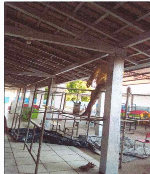
FOTO 52 APLICAÇÃO DE TINTA ESMALTE EM MADEIRA
