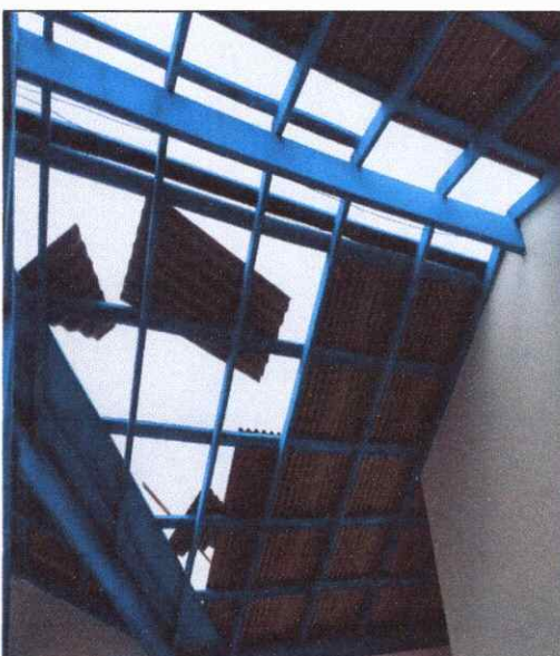
FOTO 157 EXECUÇÃO DE TRAMA E TELHAMENTO
