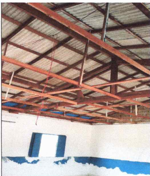
FOTO 119 ANTES DA MANUTENÇÃO
