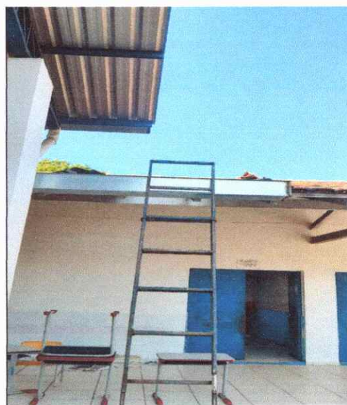
FOTO 32 INSTALAÇÃO DE CALHA EM CHAPA DE ZINCO
