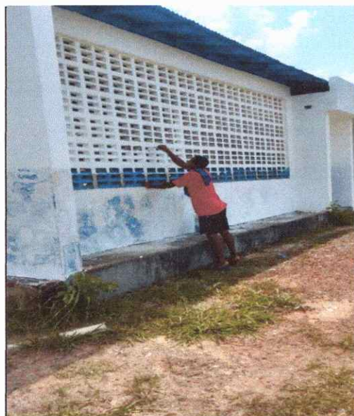
FOTO 137 APLICAÇÃO DE TINTA ACRILICA
