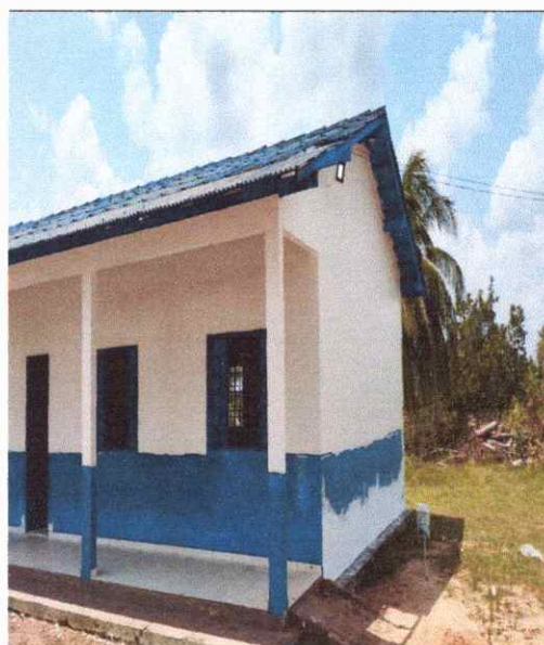
FOTO 134 APLICAÇÃO DE TINTA ACRILICA
