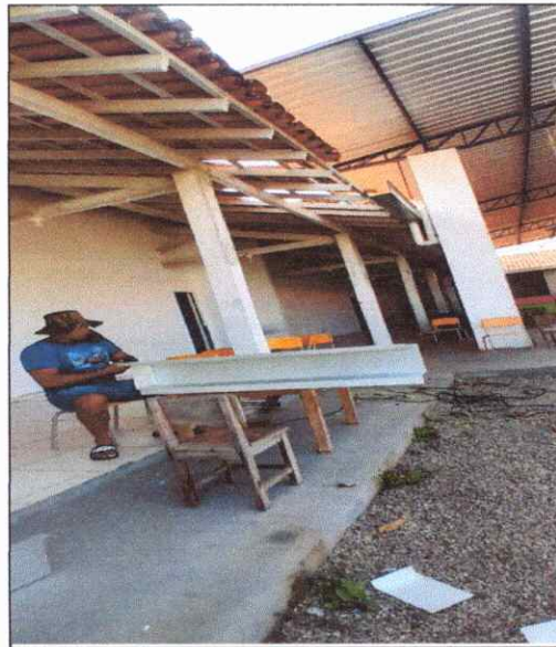
FOTO 30 INSTALAÇÃO DE CALHA EM CHAPA DE ZINCO
