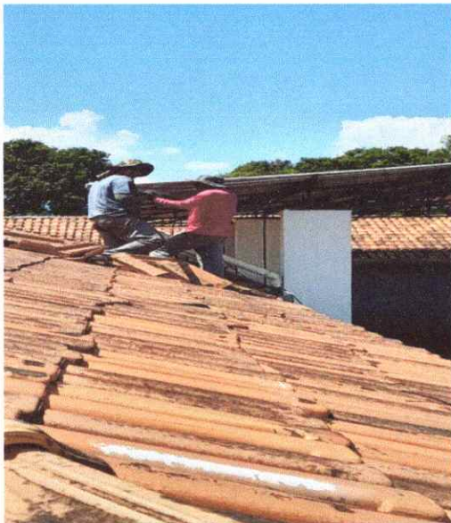
FOTO 29 MANUTENÇÃO EM TRAMA DE MADEIRA
