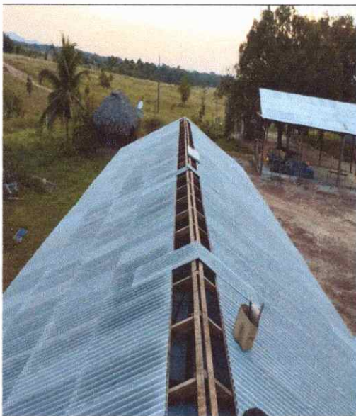
FOTO 155 EXECUÇÃO DE TRAMA E TELHAMENTO
