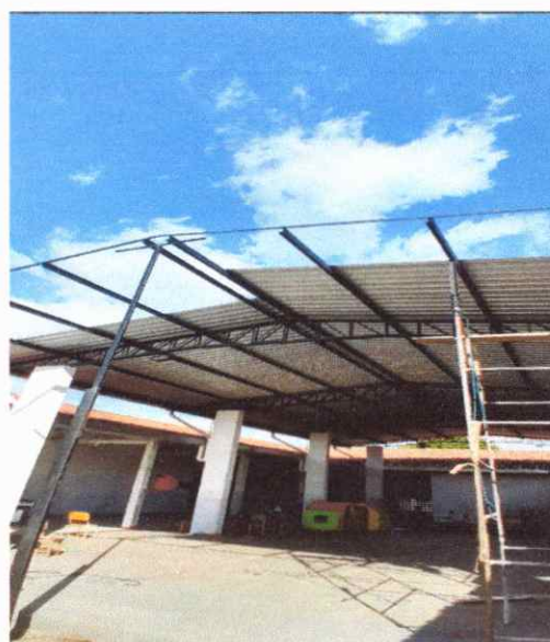
FOTO 8 MONTAGEM ESTRUTURA COBERTURA
