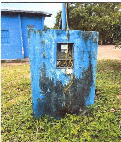
FOTO 115 ANTES DA MANUTENÇÃO
