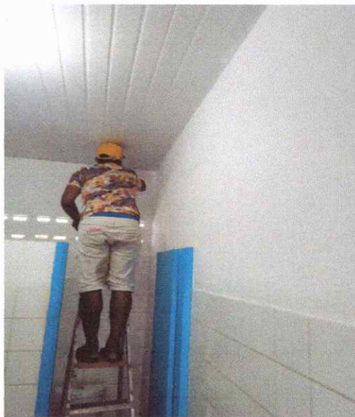
FOTO 46 APLICAÇÃO DE TINTA ACRILICA
