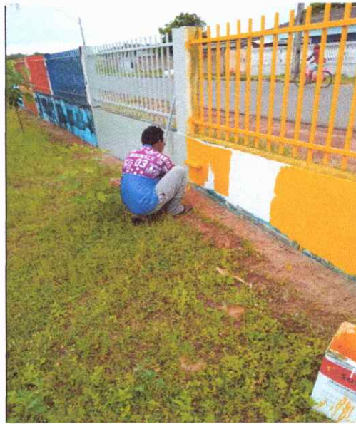
FOTO 76 APLICAÇÃO DE TINTA ACRILICA EM MURO
