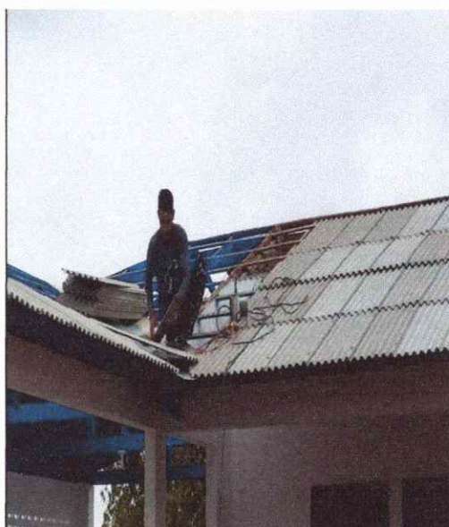
FOTO 158 EXECUÇÃO DE TRAMA E TELHAMENTO
