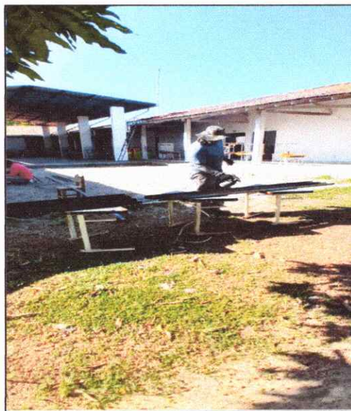
FOTO 28 MONTAGEM ESTRUTURA COBERTURA
