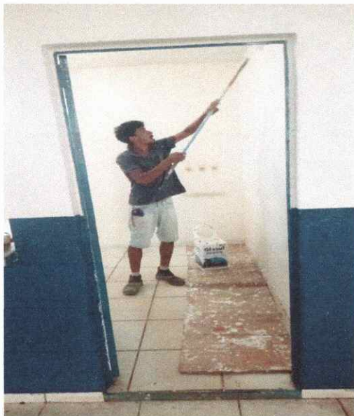
FOTO 73 APLICAÇÃO DE TINTA ACRILICA
