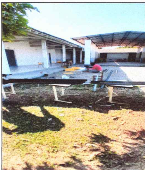
FOTO 27 MONTAGEM ESTRUTURA COBERTURA
