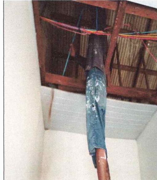
FOTO 136 INSTALAÇÃO E EXECUÇÃO DE FORRO
