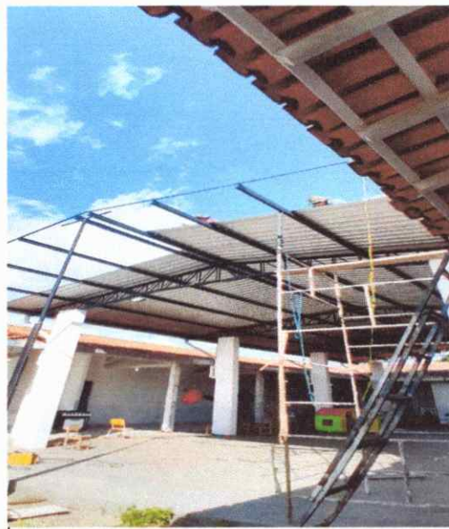
FOTO 6 MONTAGEM ESTRUTURA COBERTURA
