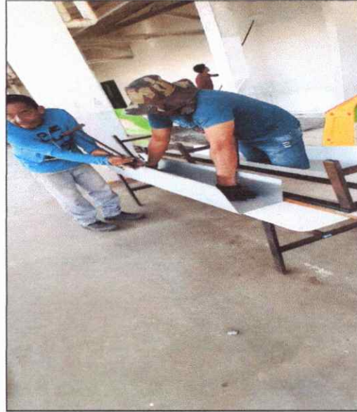
FOTO 34 INSTALAÇÃO DE CALHA EM CHAPA DE ZINCO
