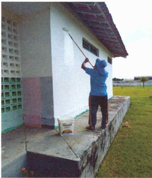
FOTO 45 APLICAÇÃO DE TINTA ACRILICA
