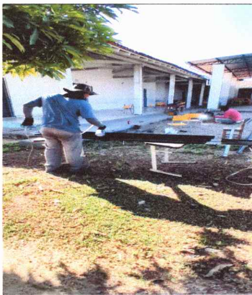
FOTO 26 MONTAGEM ESTRUTURA COBERTURA
