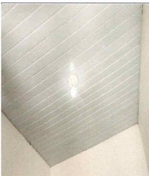
FOTO 133 INSTALAÇÃO E EXECUÇÃO DE FORRO
