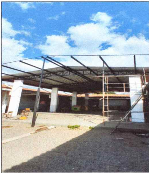
FOTO 5 MONTAGEM ESTRUTURA COBERTURA
