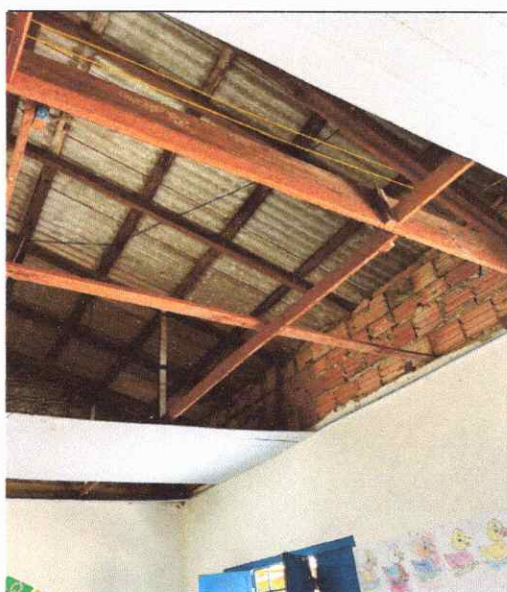
FOTO 95 ANTES DA MANUTENÇÃO
