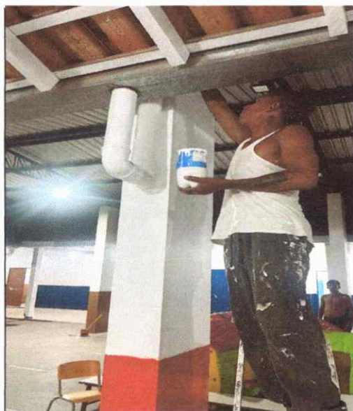
FOTO 55 APLICAÇÃO DE TINTA ESMALTE EM MADEIRA
