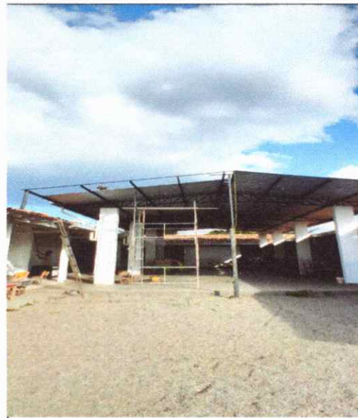
FOTO 14 MONTAGEM ESTRUTURA COBERTURA
