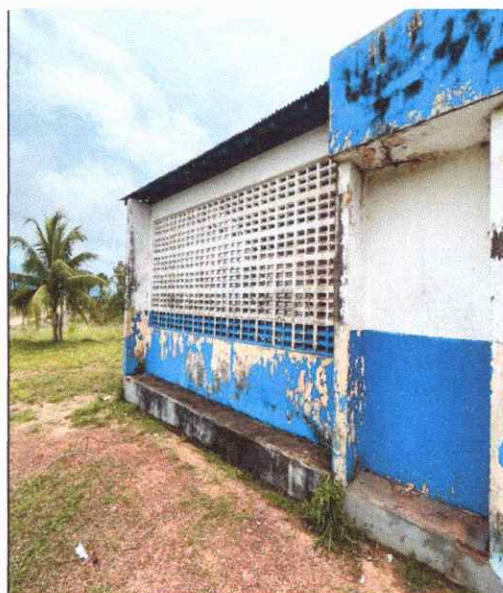
FOTO 116 ANTES DA MANUTENÇÃO
