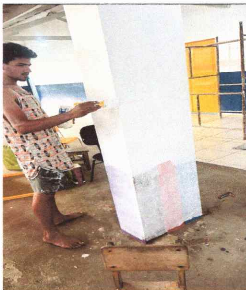
FOTO 56 APLICAÇÃO DE TINTA ACRILICA
