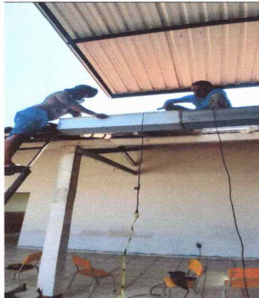
FOTO 36 INSTALAÇÃO DE CALHA EM CHAPA DE ZINCO
