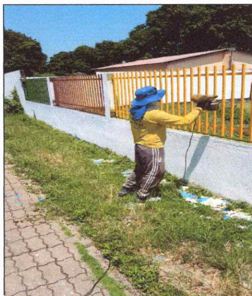
FOTO 75 APLICAÇÃO DE TINTA ESMALTE SINTETICO EM GRADE
