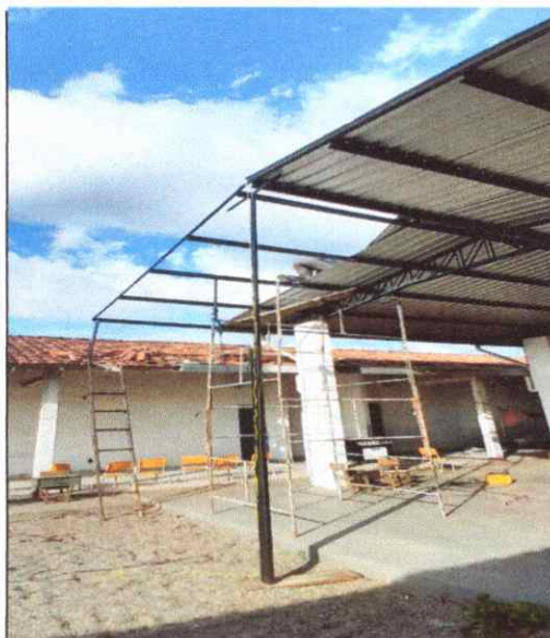
FOTO 15 MONTAGEM ESTRUTURA COBERTURA
