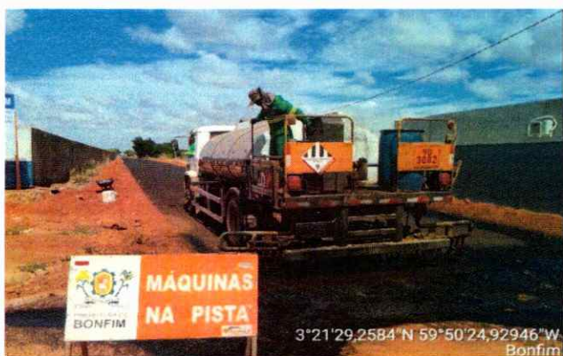
PAVIMENTAÇÃO Pintura de Ligação
