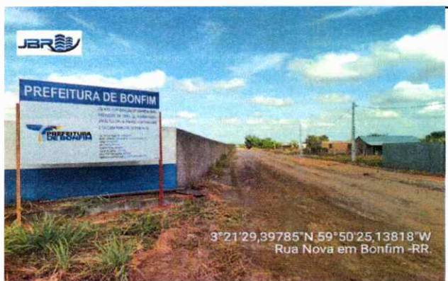
PAVIMENTAÇÃO Execução base.
