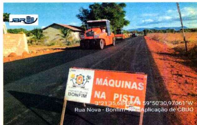
PAVIMENTAÇÃO Aplicação de CBUQ
