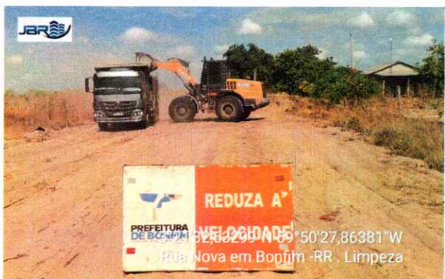
TERRAPLANAGEM Execução de limpeza.
