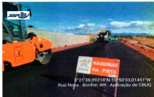
PAVIMENTAÇÃO Aplicação de CBUQ
