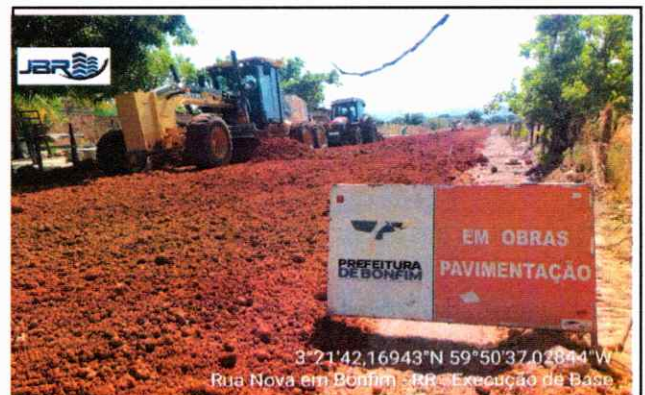
PAVIMENTAÇÃO Execução base.
