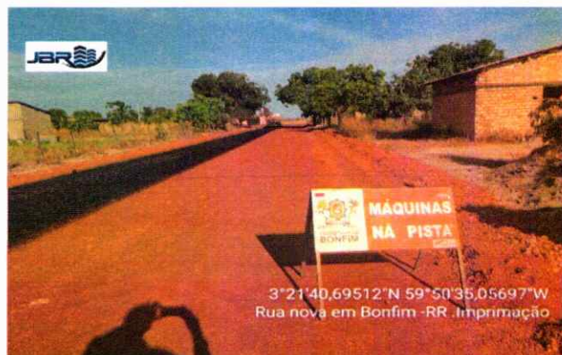
PAVIMENTAÇÃO Execução de Imprimação
