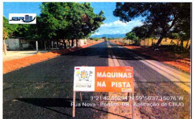
PAVIMENTAÇÃO Aplicação de CBUQ
