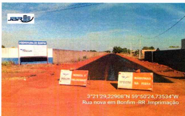
PAVIMENTAÇÃO Execução de Imprimação
