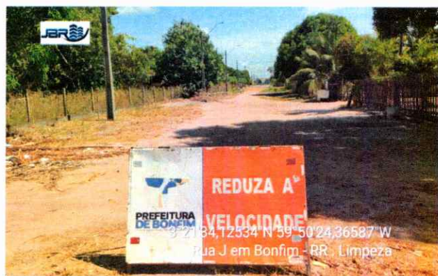
TERRAPLANAGEM Execução de limpeza.
