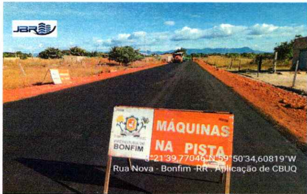
PAVIMENTAÇÃO Aplicação de CBUQ
