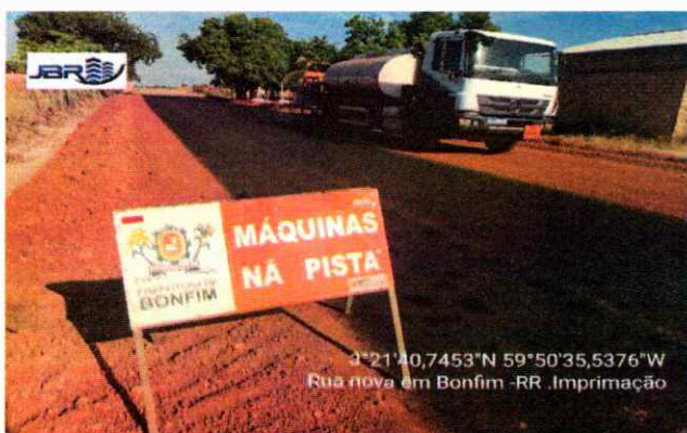
PAVIMENTAÇÃO Execução de Imprimação
