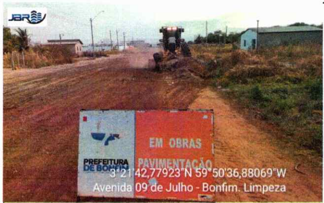
TERRAPLANAGEM Execução de limpeza.
