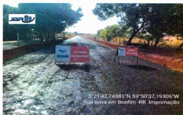
PAVIMENTAÇÃO Execução de Imprimação
