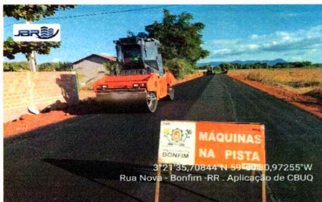
PAVIMENTAÇÃO Aplicação de CBUQ
