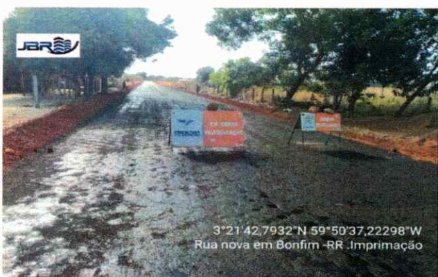
PAVIMENTAÇÃO Execução de Imprimação
