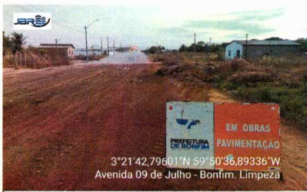
TERRAPLANAGEM Execução de limpeza.
