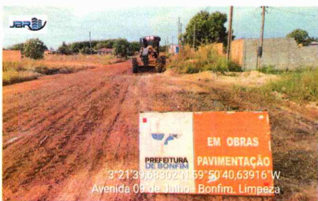
TERRAPLANAGEM Execução de limpeza.
