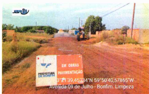
TERRAPLANAGEM Execução de limpeza.
