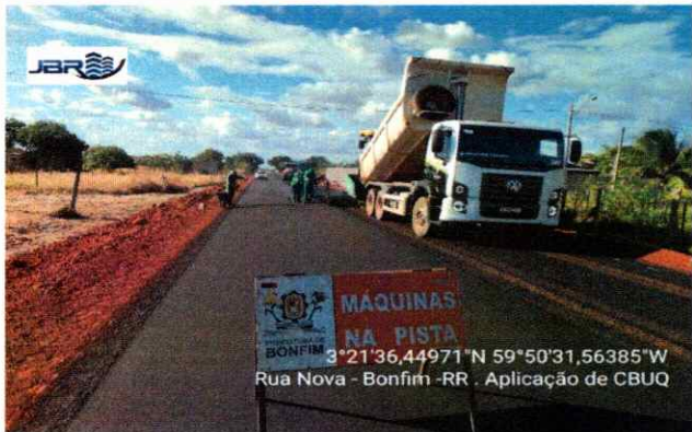
PAVIMENTAÇÃO Aplicação de CBUQ
