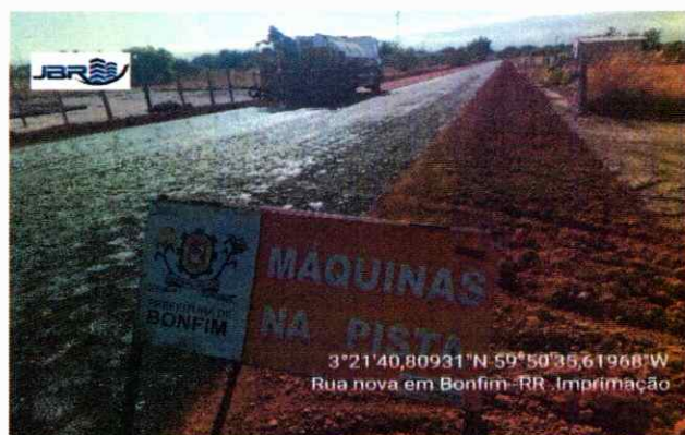
PAVIMENTAÇÃO Execução de Imprimação
