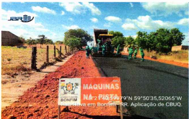
PAVIMENTAÇÃO Aplicação de CBUQ
