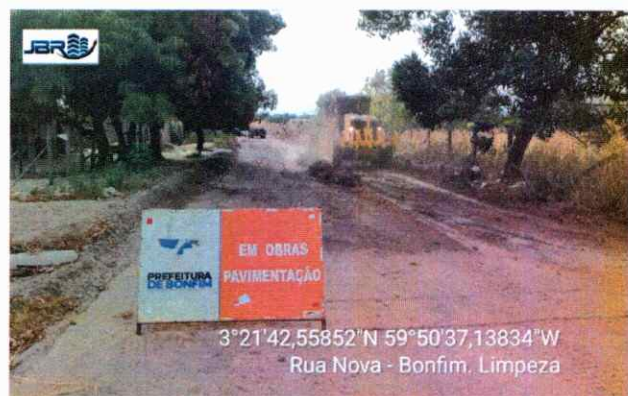
TERRAPLANAGEM Execução de limpeza.
