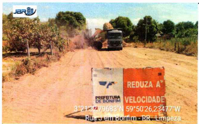
TERRAPLANAGEM Execução de limpeza.
