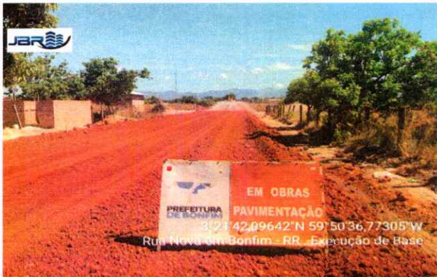
PAVIMENTAÇÃO Execução base.
