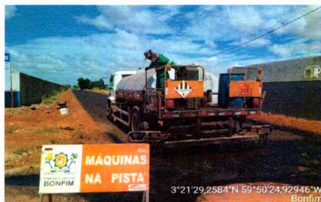
PAVIMENTAÇÃO Pintura de Ligação
