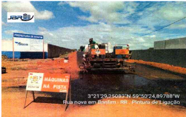
PAVIMENTAÇÃO Pintura de Ligação
