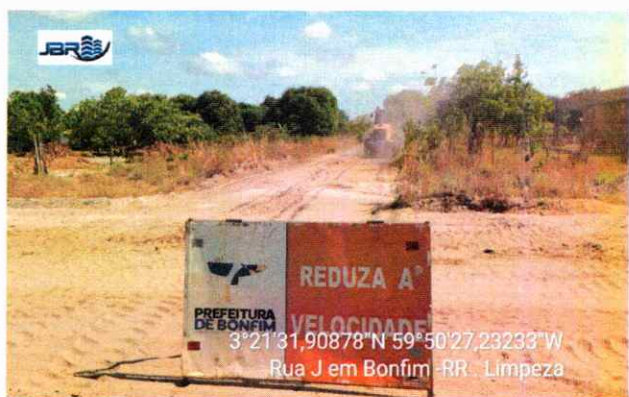
TERRAPLANAGEM Execução de limpeza.
