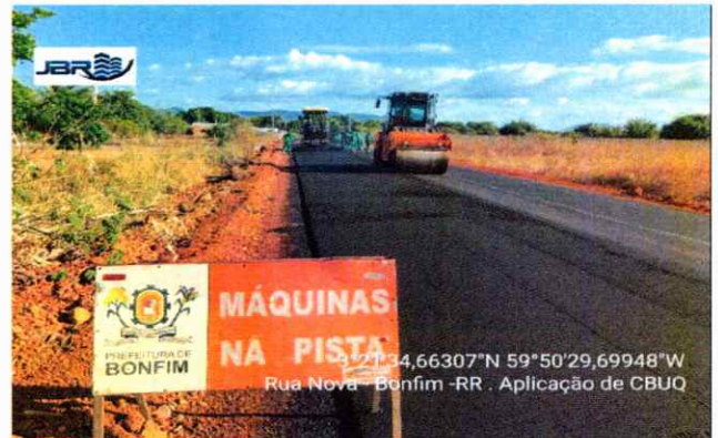
PAVIMENTAÇÃO Aplicação de CBUQ
