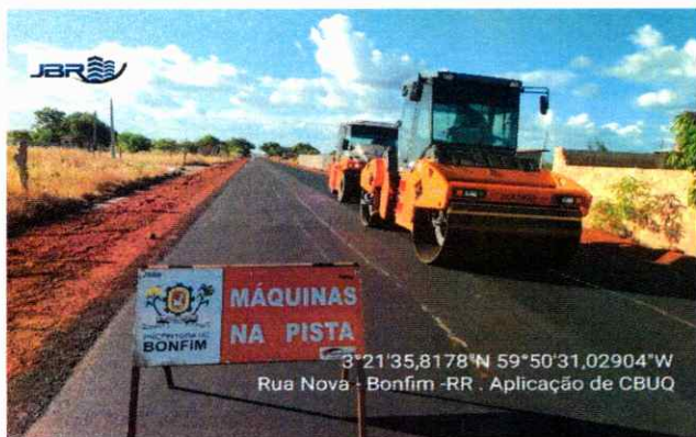
PAVIMENTAÇÃO Aplicação de CBUQ
