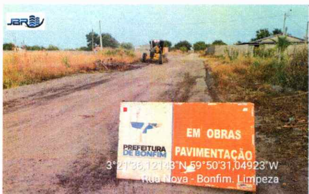
TERRAPLANAGEM Execução de limpeza.
