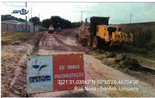
TERRAPLANAGEM Execução de limpeza.
