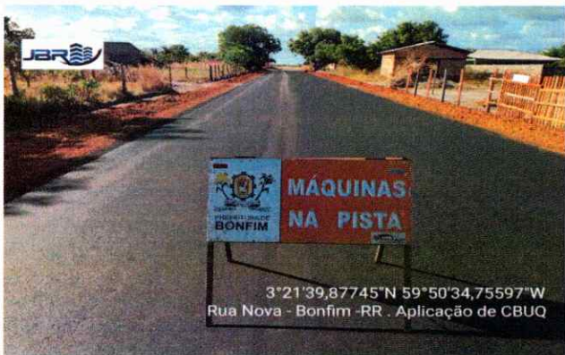
PAVIMENTAÇÃO Aplicação de CBUQ
