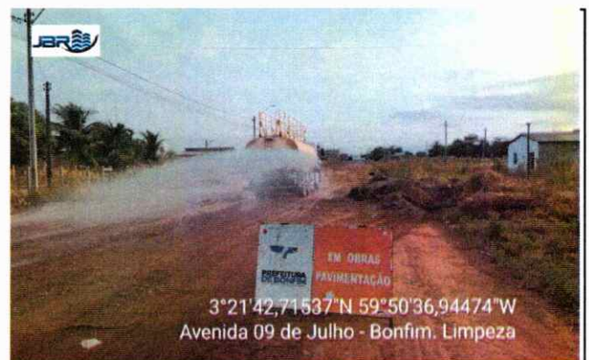
TERRAPLANAGEM Execução de limpeza.
