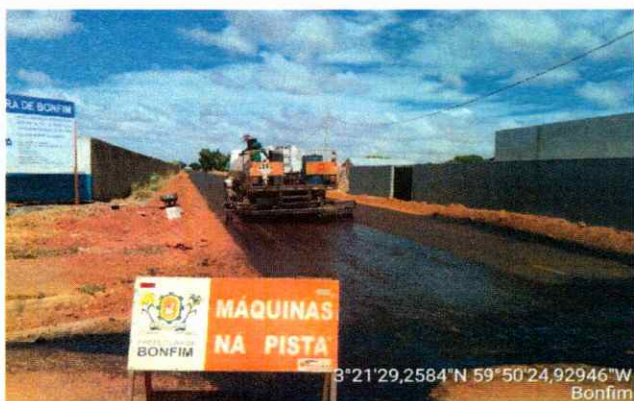
PAVIMENTAÇÃO Pintura de Ligação
