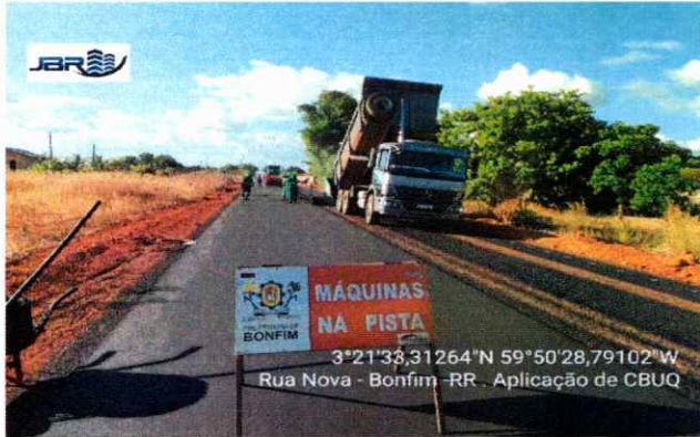
PAVIMENTAÇÃO Aplicação de CBUQ
