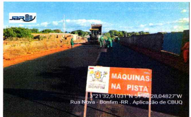
PAVIMENTAÇÃO Aplicação de CBUQ
