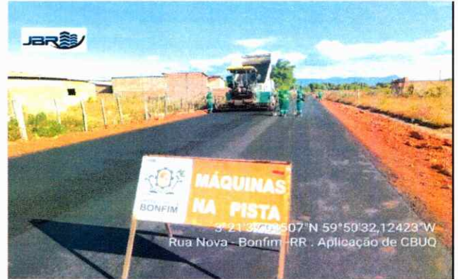
PAVIMENTAÇÃO Aplicação de CBUQ
