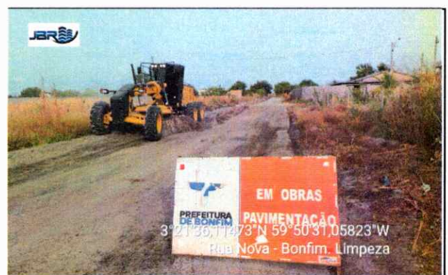
TERRAPLANAGEM Execução de limpeza.
